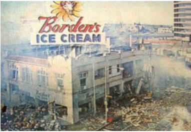
Uszkodzenia budynku w wyniku wybuchu amoniaku Houston w 1983 r.
